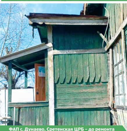
ФАП с. Дунаево, Сретенская ЦРБ – до ремонта
