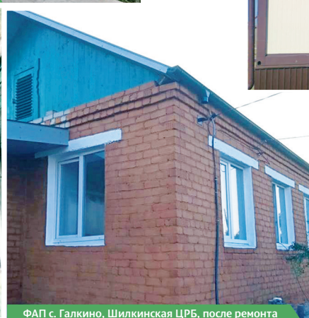
ФАП с. Галкино, Шилкинская ЦРБ, после ремонта
